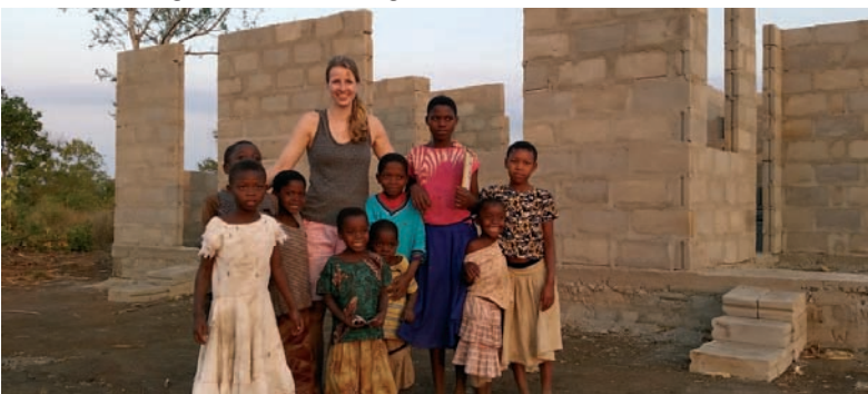
Rohbau des neuen Waisenhauses in Miono Tansania
