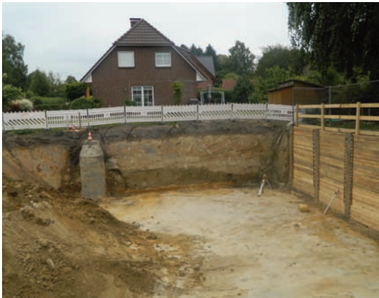
Baugrube am Blomeweg
