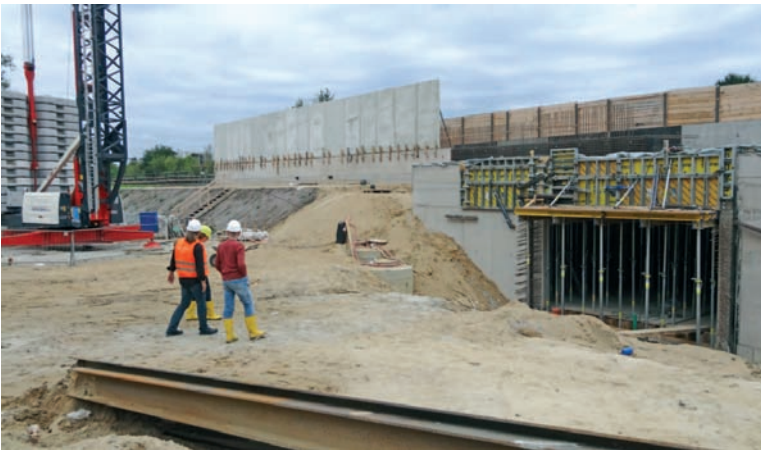
Halbzeitstand der Bauarbeiten
