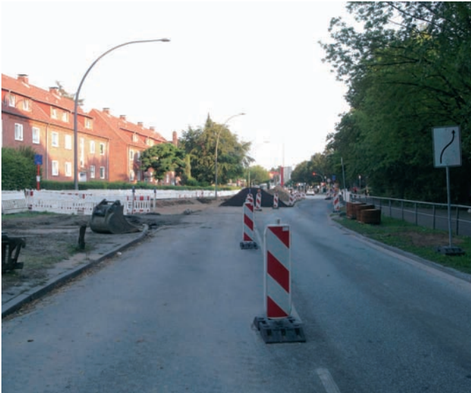
Baustelle in Richtung Rahlstedt
