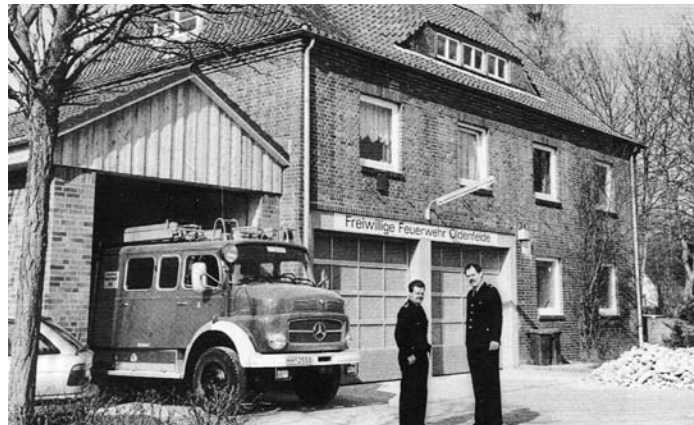
Anbau am Spritzenhaus 1995, rechts Wehrführer Gansel
