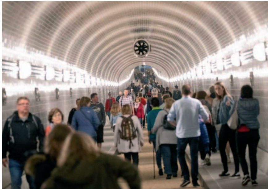
Fußgänger im renovierten Tunnel
