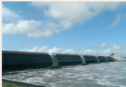
5 Schotten sperren das Wasser aus
