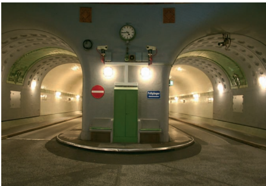
die beiden Röhren jeweils Einbahnstraßen
