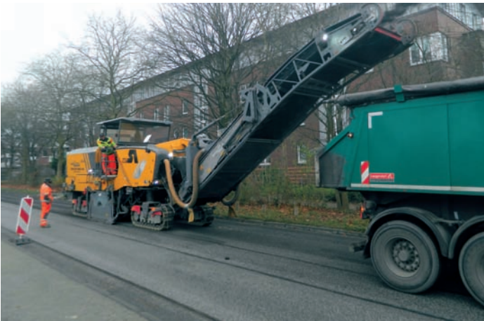
Fräsen und Beladen des LKW
