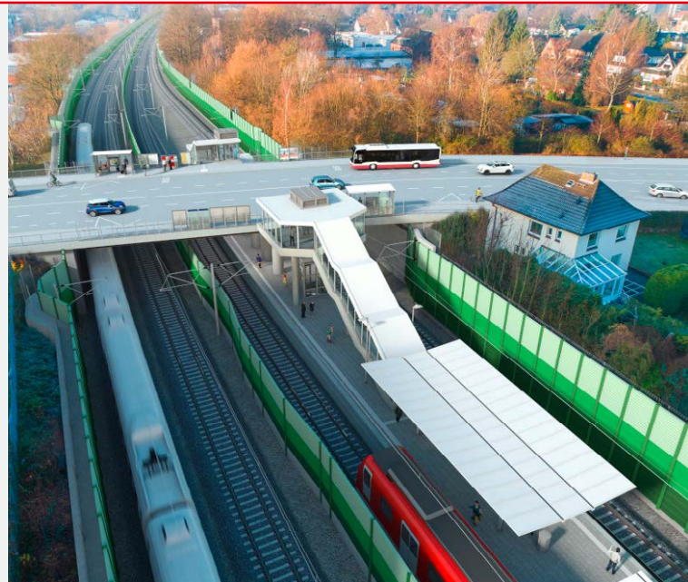
Die neue Station am Holstenhofweg.
