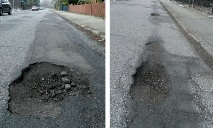
acht solcher Löcher waren zu füllen
