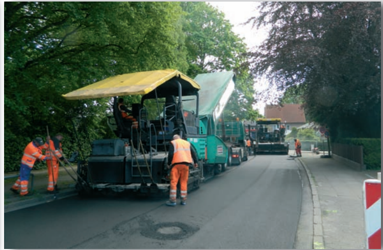
zwei Maschinen verlegen gleichzeitig den Asphalt
