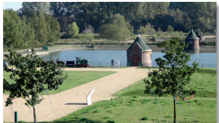
Klärbecken mit Schieberhäuschen
